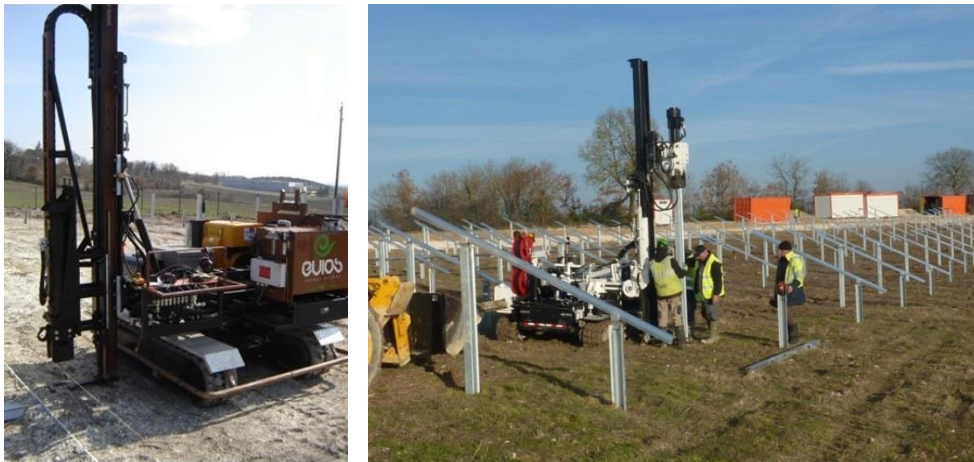
Battage des pieux
