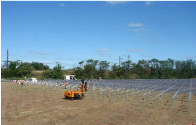
Battage des pieux
