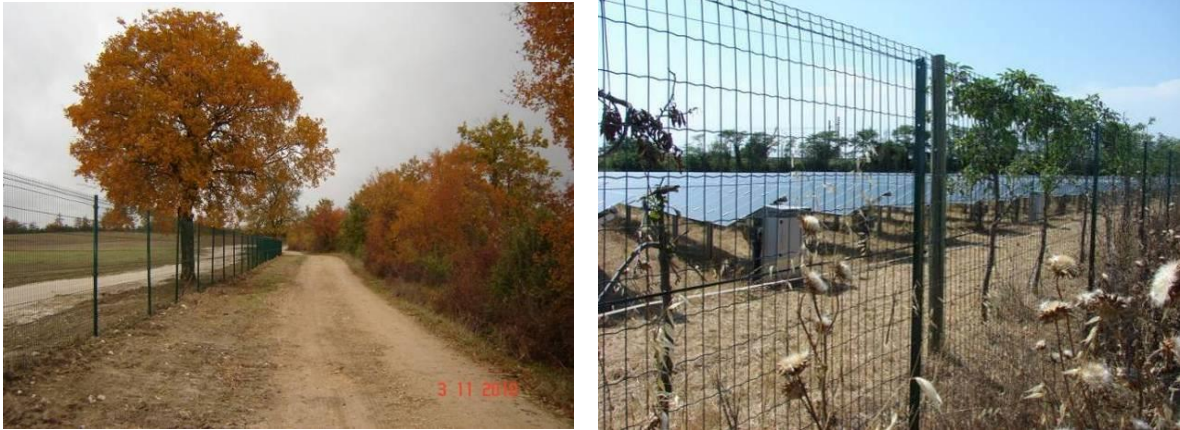
Exemples de clôture à Cahors et Lunel
