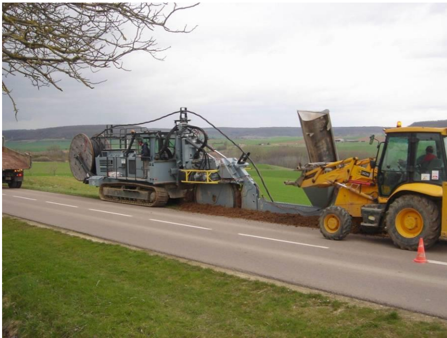
Réalisation de la tranchée, pose du câble HTA, du grillage avertisseur et remblaiement simultanés
