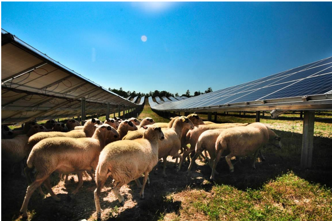
Pâturage ovin sur la centrale solaire du Sycala
