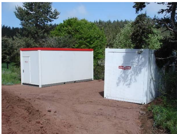
Vestiaires et bureaux de chantier
