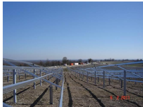
Fixation des rails de support
