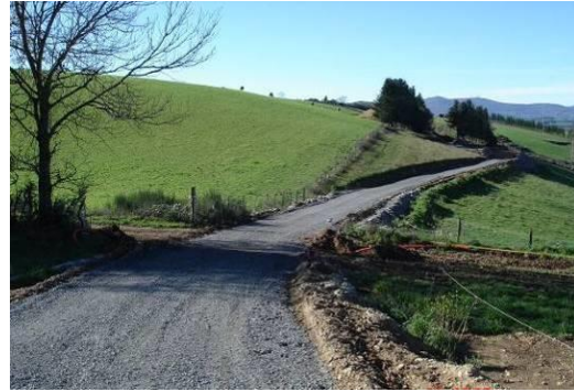
Pose du géotextile
