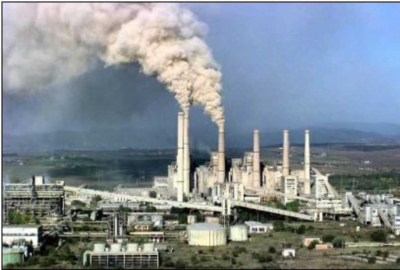
Centrale électrique thermique
