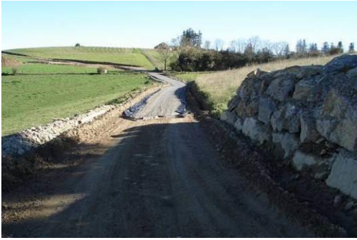
Mise en place de matériau d'emprunt
