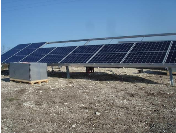
Pose des modules, centrale solaire du Sycala
